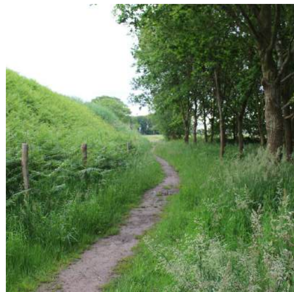
(27) Door het Laarzenpad langs het oud vliegveld in Aalter concaaf aan te walsen, bleef het pad langs het oud vliegveld in Aalter zelfs tijdens het uiterst natte voorjaar van 2024 zeer goed toegankelijk.
