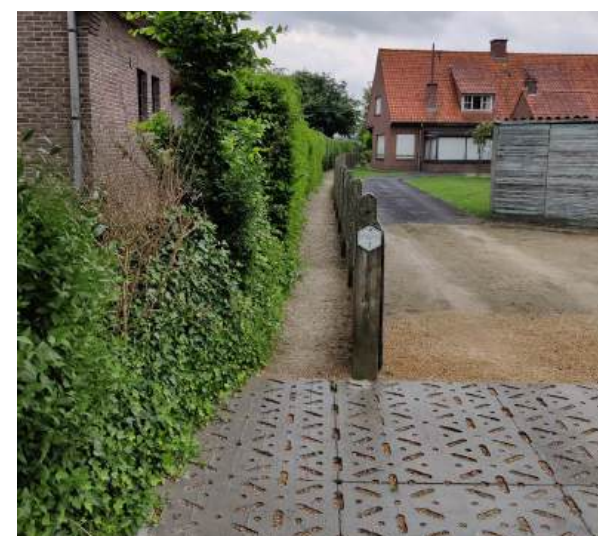
(37) Aan de Kruisstraat in Zulte werd de halfverharding extra verstevigd met geperforeerde betonplaten ter hoogte van een draaipunt bij de boerderij.
